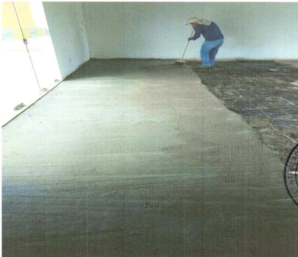
FOTO 14 - EXECUÇÃO DO CONTRAPISO PARA PISO DE ALTA RESISTÊNCIA
