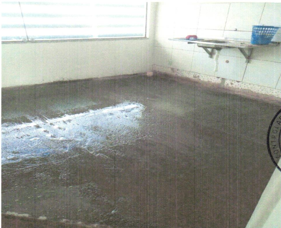
FOTO 16 – EXECUÇÃO DO PISO DE ALTA RESISTÊNCIA
