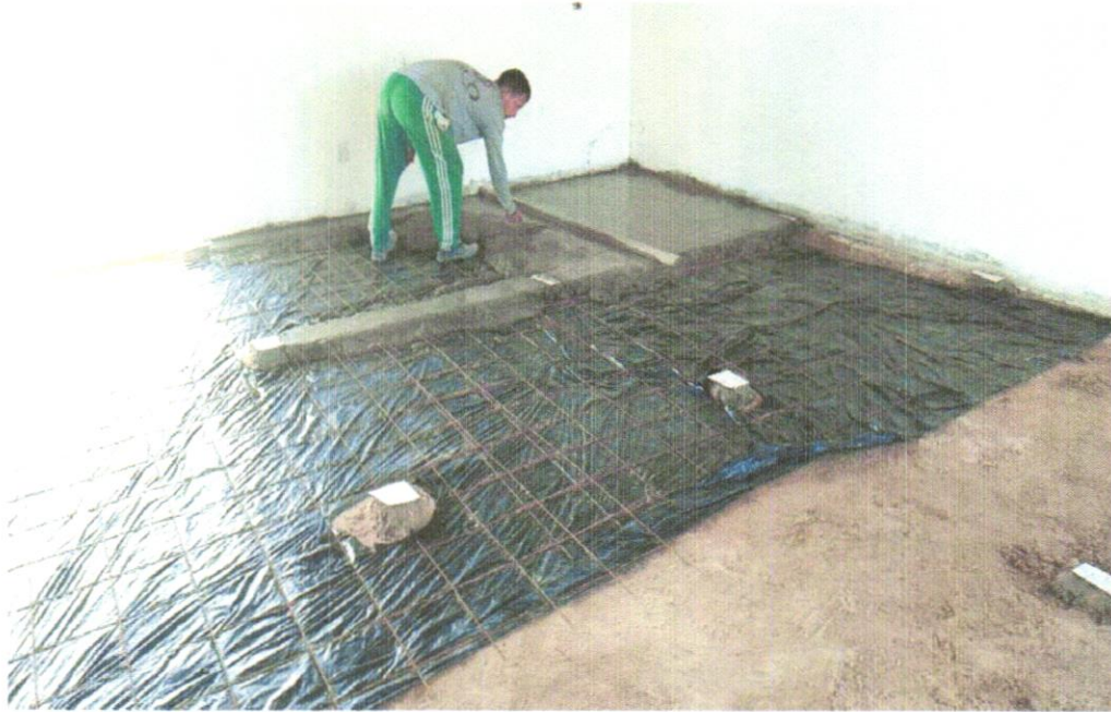
FOTO 14 - EXECUÇÃO DO CONTRAPISO PARA PISO DE ALTA RESISTÊNCIA
