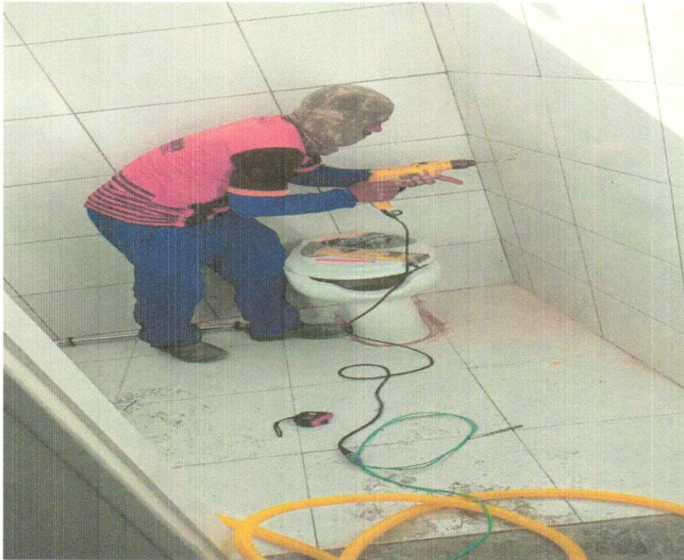
FOTO 12 – INSTALAÇÃO DA BARRA DE APOIO SANITÁRIO PCD
