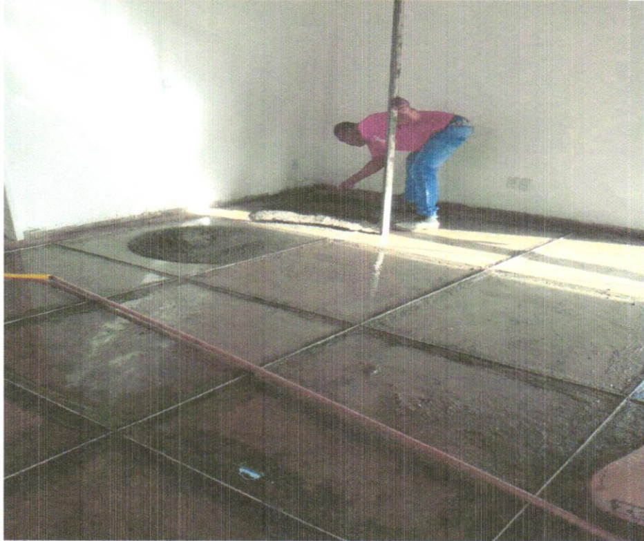
FOTO 16 – EXECUÇÃO DO PISO DE ALTA RESISTÊNCIA
