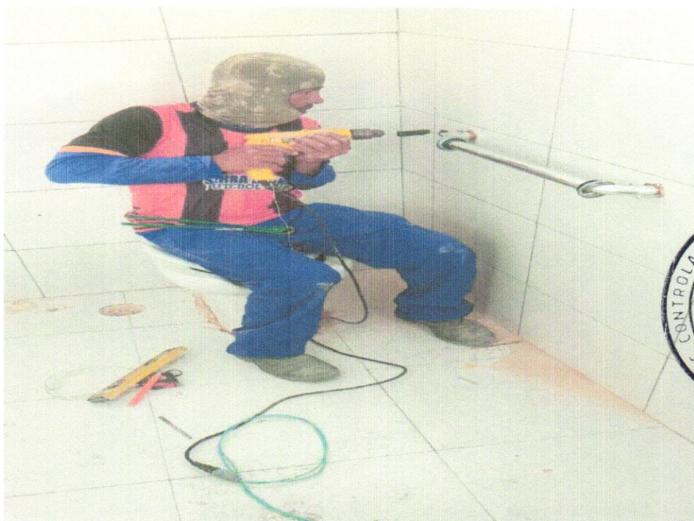
FOTO 12 – INSTALAÇÃO DA BARRA DE APOIO SANITÁRIO PCD
