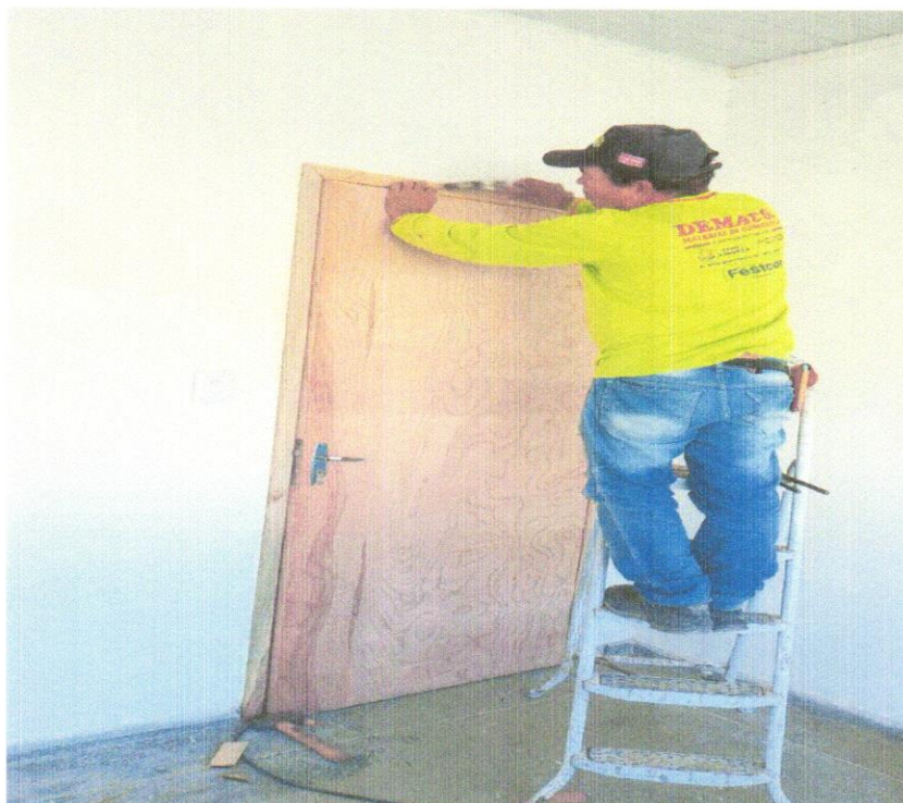
FOTO 02 – INSTALAÇÃO DE PORTAS DE MADEIRA INCLUSIVE ALIZAR
