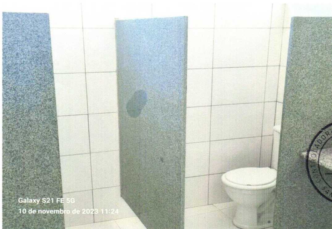
FOTO 06 - DIVISÓRIAS DE GRANITO SANITÁRIO FEMININO
