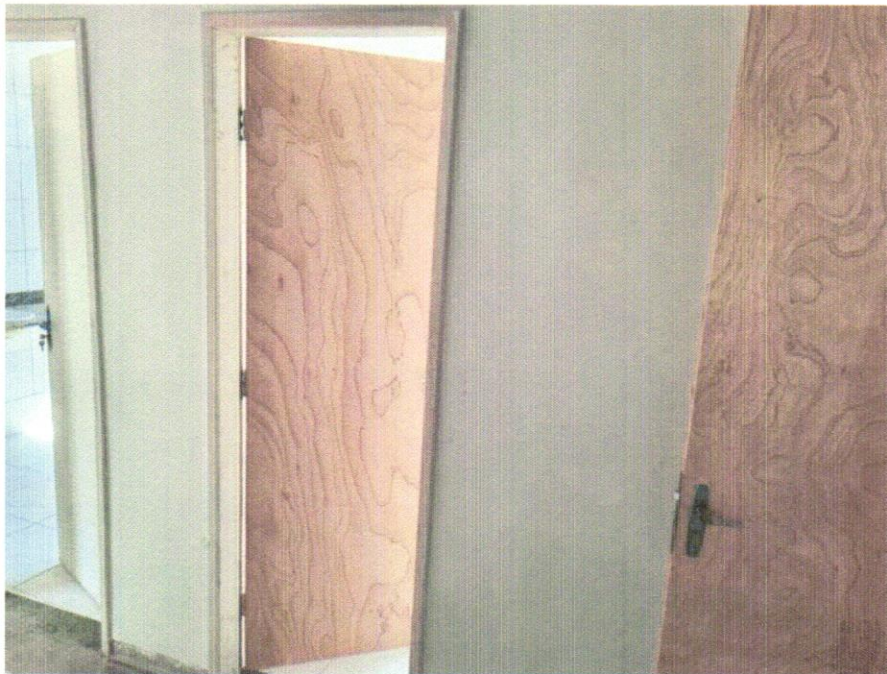
FOTO 02 – INSTALAÇÃO DE PORTAS DE MADEIRA INCLUSIVE ALIZAR
