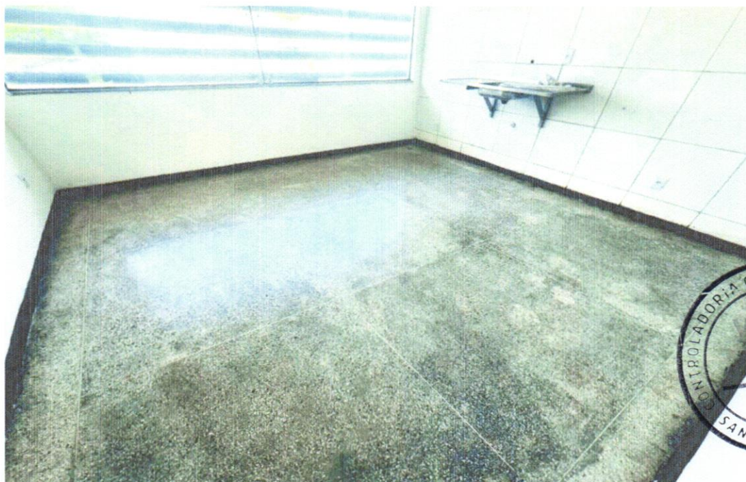
FOTO 18 – POLIMENTO DO PISO DE ALTA RESISTÊNCIA
